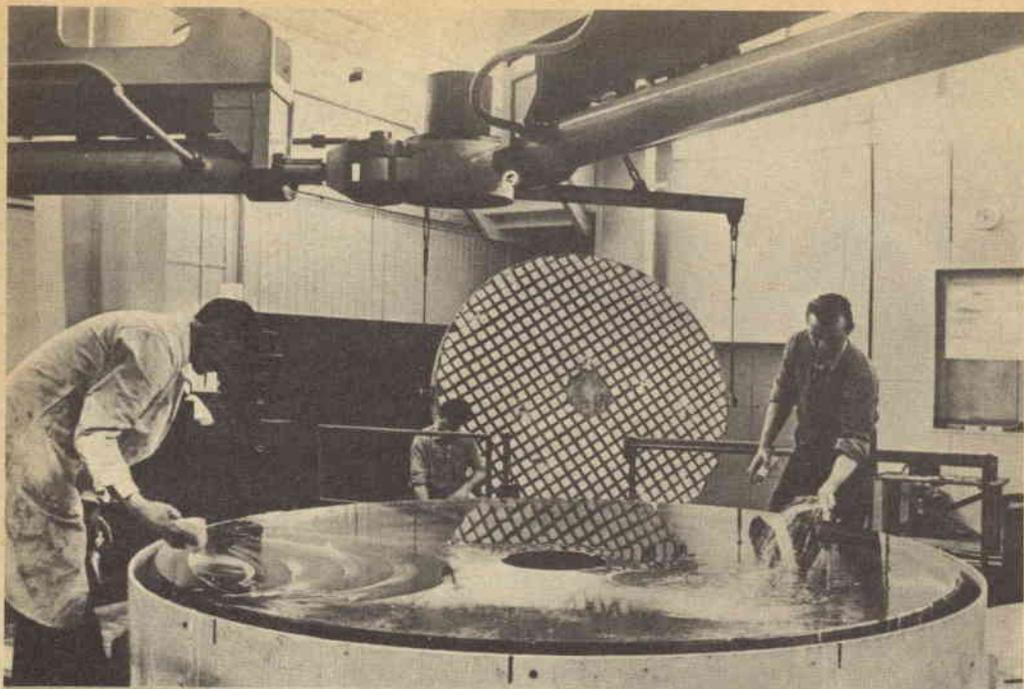
Pulitura dello specchio del telescopio Isaac Newton.
