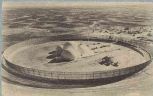
In questo sistema radar sperimentale, progettato dalla Sylvania per individuare e seguire i missili nemici, anziché un'unica antenna a disco rotante vengono impiegati molti elementi d'antenna. La deflessione del fascio radar viene ottenuta elettronicamente variando la fase elettrica di singoli elementi.
